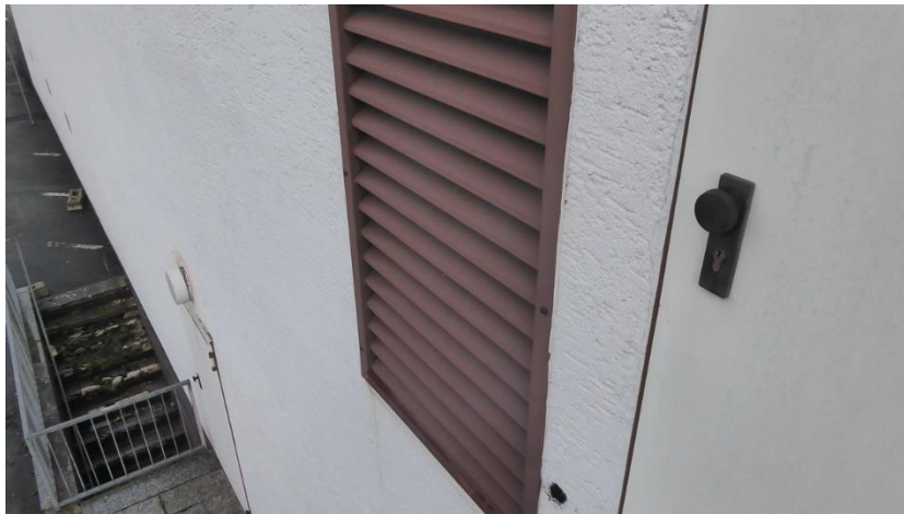
Foto 14 Hinter den Lamellen befindet sich ein Gittergeflecht, so dass keine Tiere in das Gebäude eindringen können.
