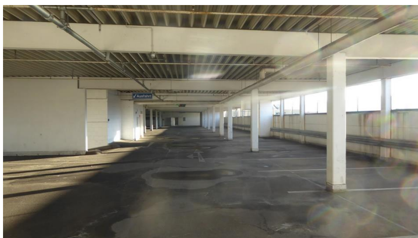
Foto 27 Oberstes Stockwerk des Parkhauses.
