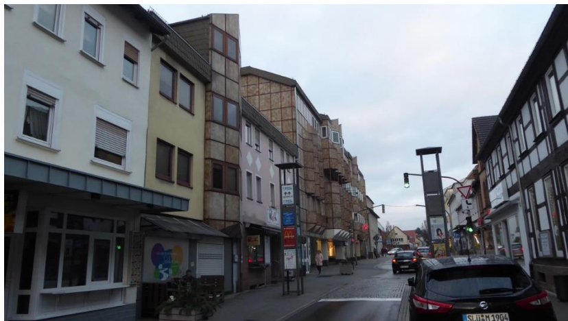
Foto 1 Blick auf das Kaufhaus „Langer“ aus Richtung Süden. Dazugehörig sind auch das separate Gebäude im Kaufhaus-Design sowie das Gebäude mit der gelben Fassadenfront davor.
