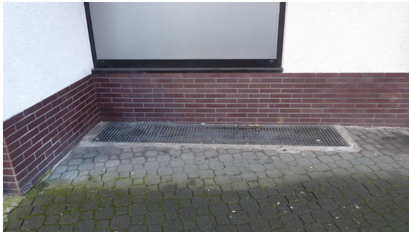
Foto 10 In der Bahnhofstraße gibt es einige Kellerluken mit Gitterroste. Die Kellerräume sind allerdings durch Fenster hermetisch verschlossen.
