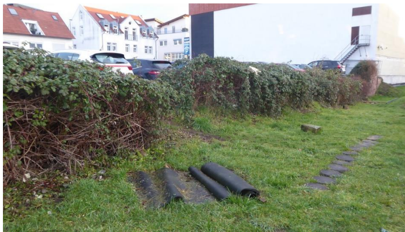
Foto 20 Mit Brombeeren bewachsenen Mauer zwischen dem Parkplatz und der Grünanlage. Sein ist als Lebensraum für Zauneidechsen geeignet.
