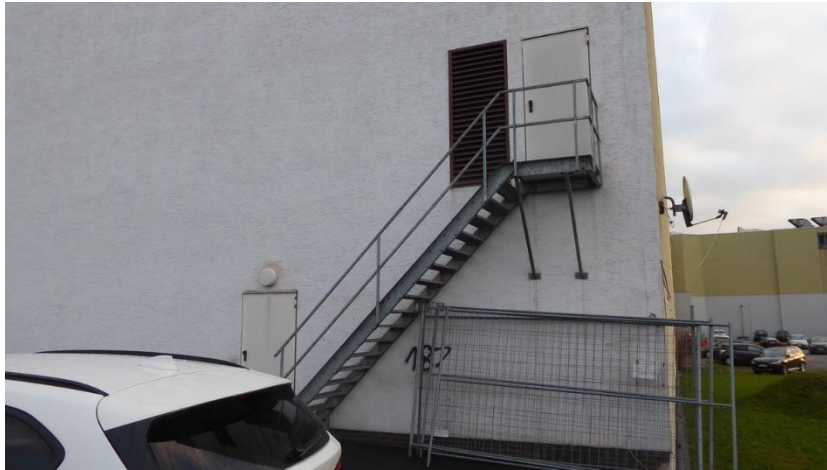
Foto 13 Treppe an der Ostfront.
