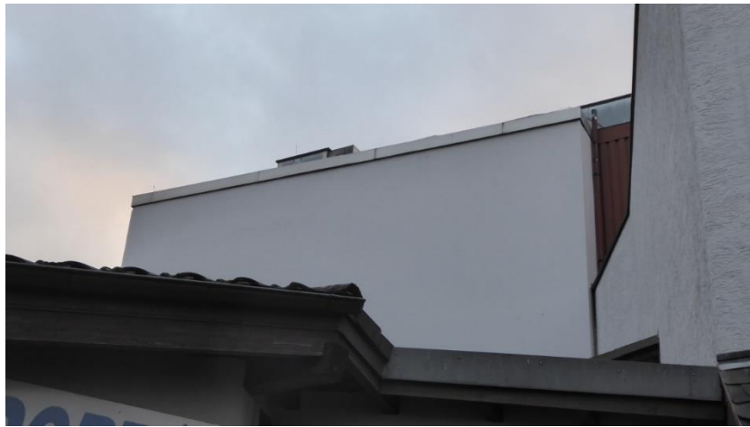
Foto 4 Fassade des Kaufhauses „Langer“ hinter dem grauen Eckhaus.
