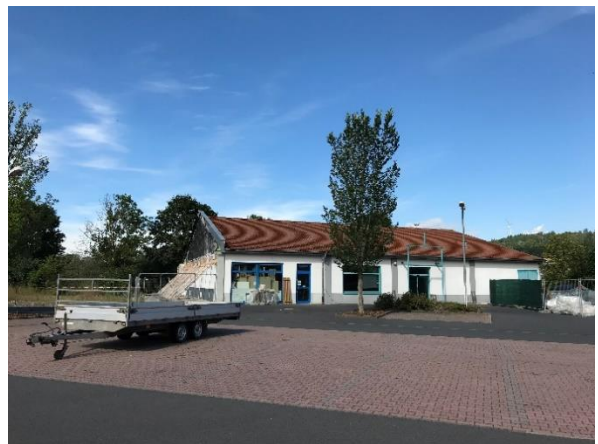
Abb. 4: Gewerbegebäude mit Parkplatz
